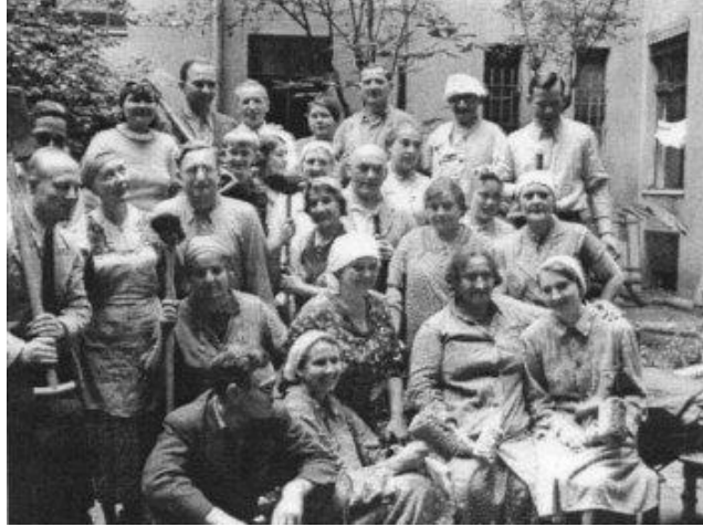
Die „Hausgemeinschaft“ beim Ausbau des Luftschuttkellers
